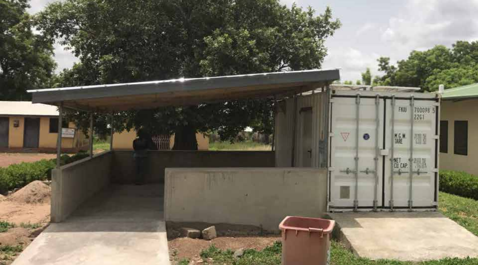
De röntgencontainer bij het ziekenhuis van Wechiau in de Upper West region. De fraaie wachtruimte biedt schaduw, beschermt tegen regen en is goed geventileerd.
