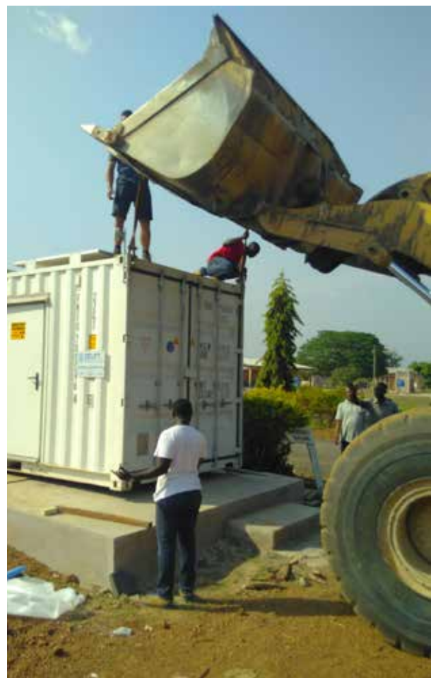
Hoe plaats je een röntgencontainer op een platform zonder toegangsweg?
